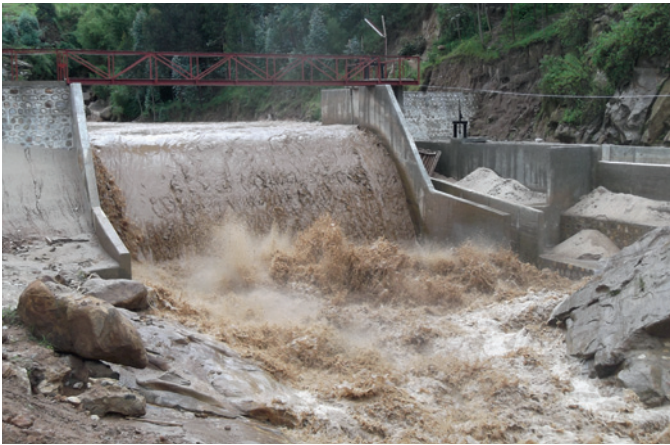
Giciye, Rwanda – Prise d'eau durant une crue
