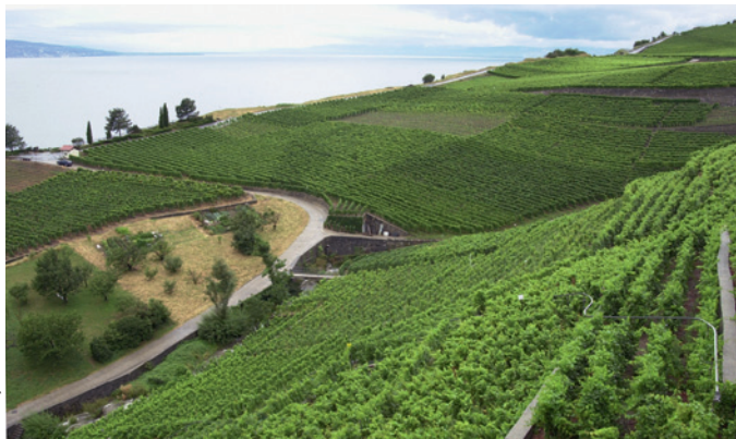
Le Lavaux, région à haute valeur patrimoniale et énergétique, préservée par la pose d'une conduite en forage dirigé pour le projet Rivaz II
