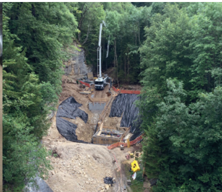
Le Day: le chantier du local de turbinage en août 2014, vu depuis le barrage
