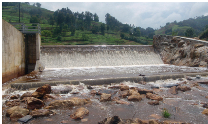
Seuil sur la Rukarara, Rwanda
