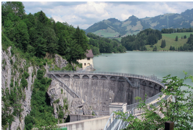
Barrage de Montsalvens (CH)
