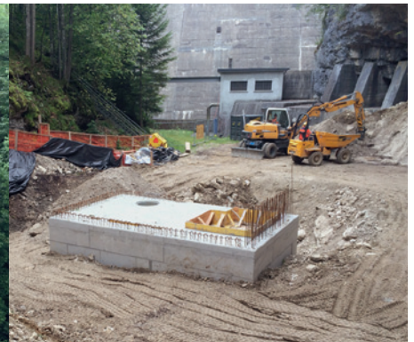
Le Day: le local de turbinage au pied du barrage en septembre 2014
