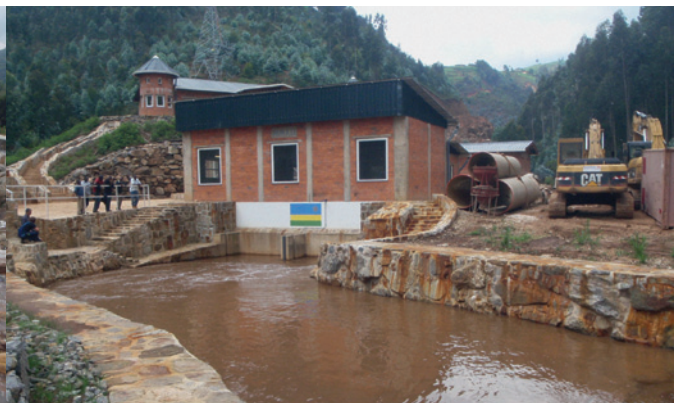
Centrale de Rukarara II, Rwanda
