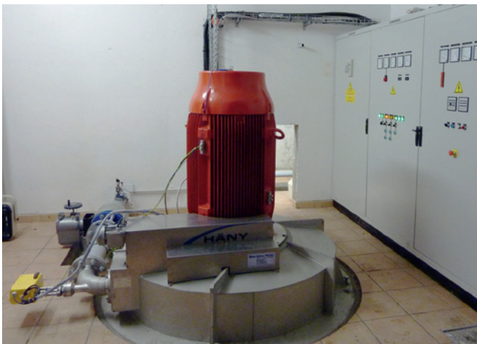
Barcelonnette (France), le turbogroupe, réalisé par Blue Water Power AG, sur la base d'un profil hydraulique Mhylab ( Q = 40 \text{ l/s} , H_n = 551 \text{ m} , P_m = 192 \text{ kW} )
